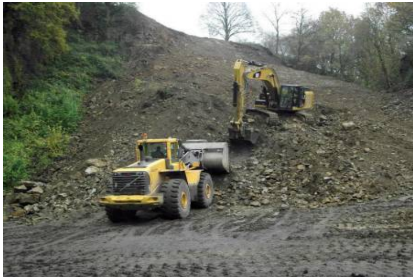
Fig. 3 - L'attaque du chantier.
