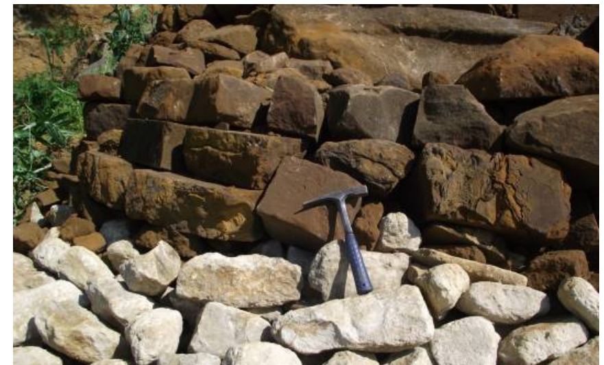
Fig. 29 - La pierre de Gobertange est surmontée du grès ferrugineux bruxellien.
