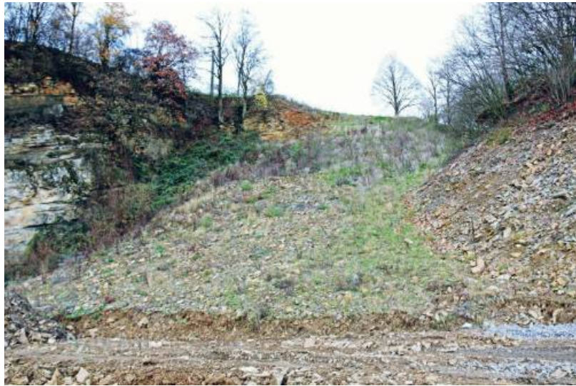
Fig. 2 - Le terrain du mur, tel qu'il était en 2015.
