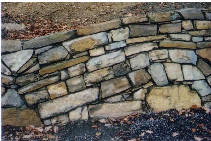
Photo 8 : plissement dans une maçonnerie sèche
